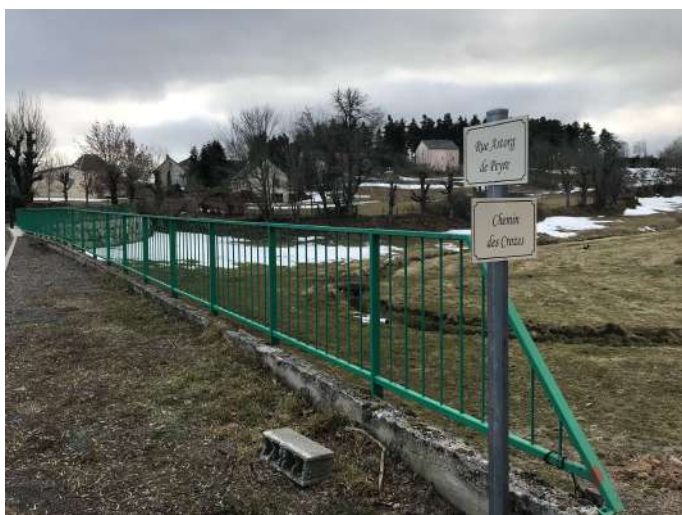
27 février : installation des plaques noms de rue
