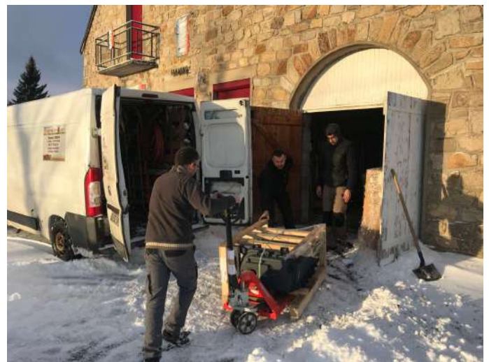
30 janvier : Changement de la chaudière du bâtiment Mairie-Ecole
